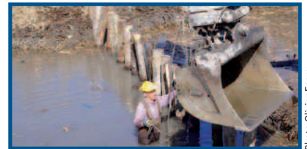
Fig. 5: Février et mars 2008, deux mois d'intenses travaux avec de grosses machines
