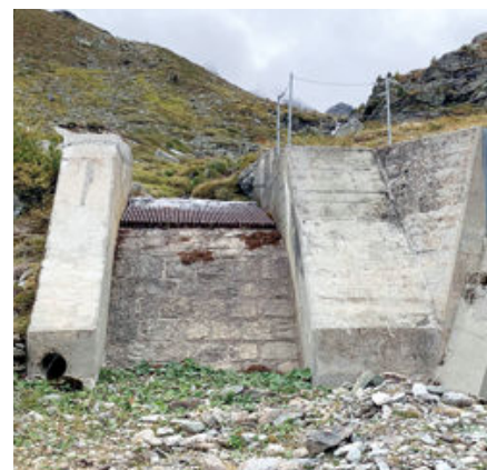
Captage du Brändjibach, affluent de la Turtmänna, sans débit résiduel Photo Marc Bernard
