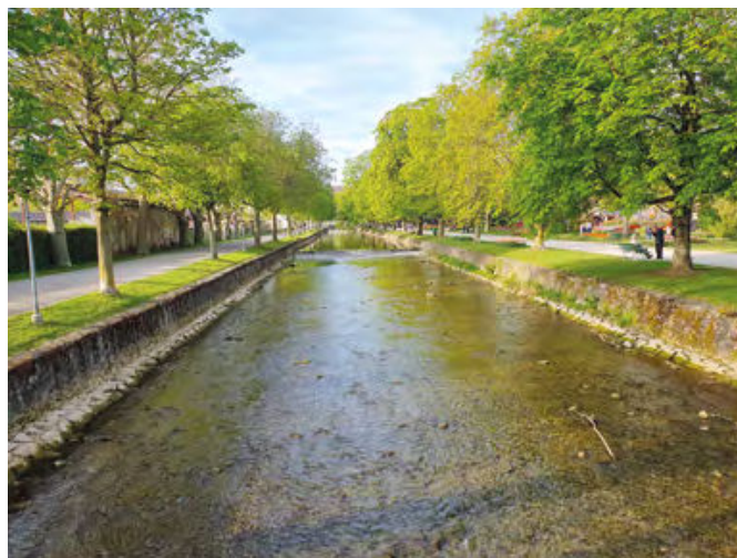
Cours d'eau canalisé avec banalisation des écoulements et absence d'habitats sur les berges. Photo Aurélie Rubin
